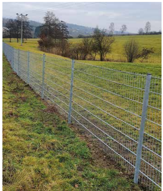
Abb. 18: Beispiel für einen Massivzaun aus Metallgitter (Foto: A. Ertl)
