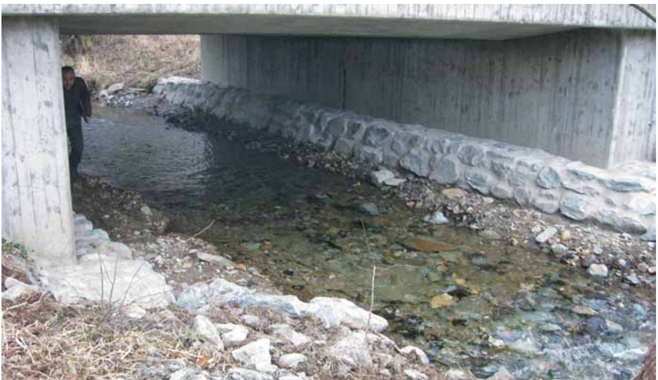
FERTIG GESTELLTE BERME (FOTO M. SCHMALZ)
