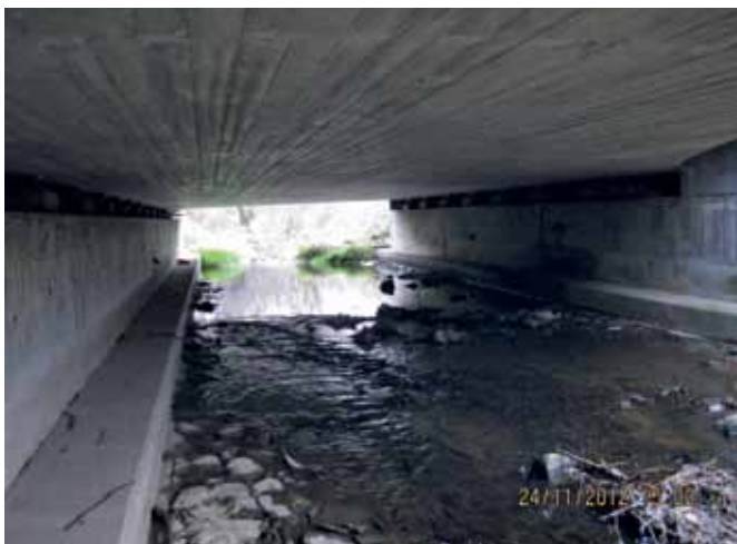
Abb. 16: LAUFSTEG MIT AUSREICHENDER BREITE (50 CM) UND HÖHE (FOTO M. SCHMALZ)
