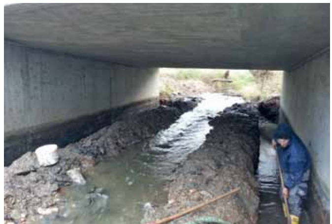
AUSSCHACHTEN DES BRÜCKENFUNDAMENTES (FOTO S. GUNKEL)
