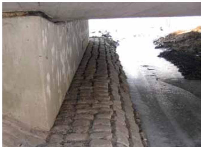
Abb. 12: SEHR GUT GEEIGNETE, GEMAUERTE BERME MIT RAUIGKEIT UND AUSREICHENDER HÖHE (FOTO: M. SCHMALZ)
