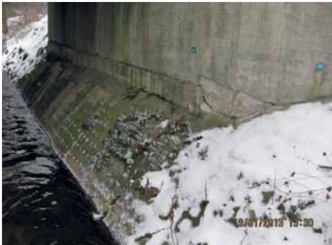
Abb. 15: DURCH EXTREM STARKE NEIGUNG UNPASSIERBARE BERME. (FOTO: M. SCHMALZ)
