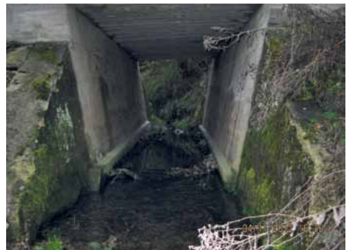
Abb. 19: ZU SCHMALER LAUFSTEG OHNE ANBINDUNG ANS UFER (FOTO M. SCHMALZ)
