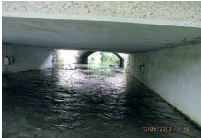
BRÜCKE VOR DEM UMBAU (FOTO M. SCHMALZ)
