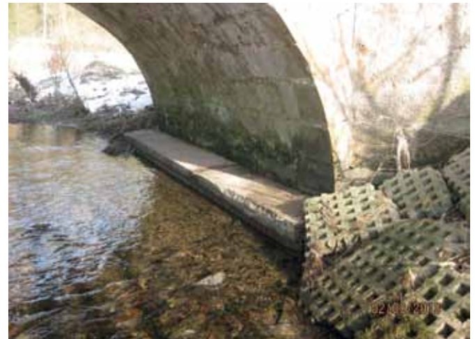
Abb. 18: ZU NIEDRIGER LAUFSTEG, DER BEREITS BEI MITTELWASSER ÜBERSCHWEMMT WIRD (FOTO M. SCHMALZ)
