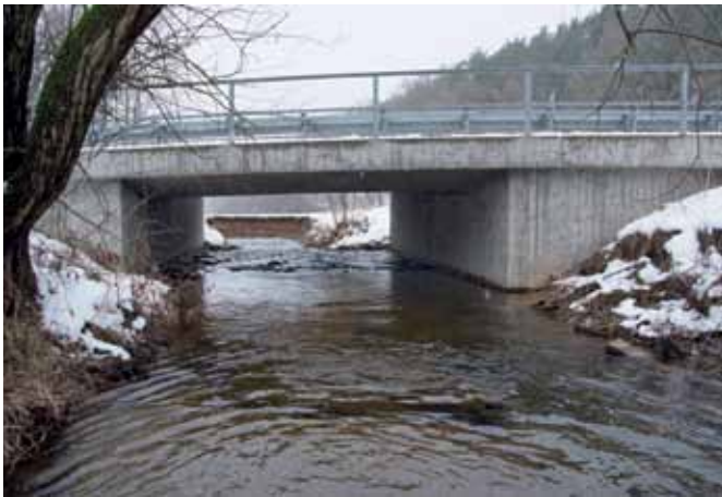
BRÜCKE VOR DEM UMBAU (FOTO S. GUNKEL)
