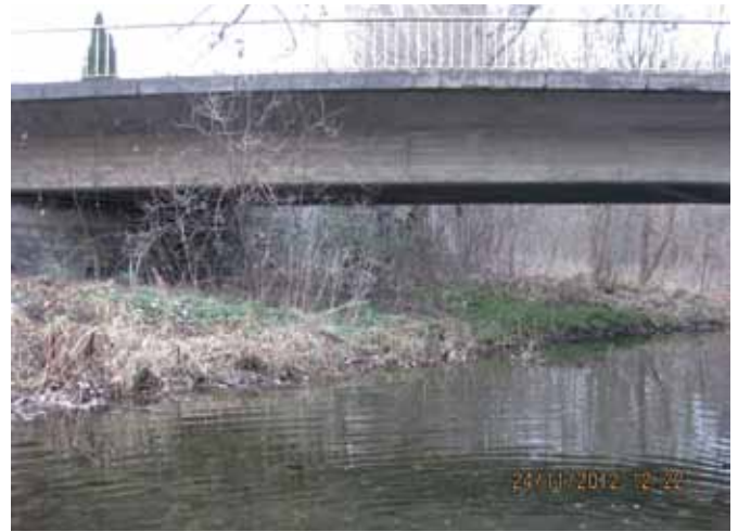
Abb. 23: Geringe Gefährdung: Brücke überspannt das Ufer weit, Berme mit natürlicher Vegetation (Foto M. Schmalz)
