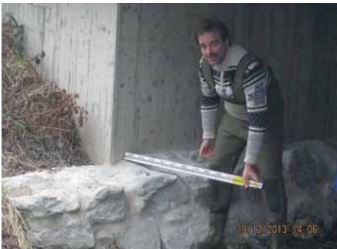
Abb. 37: Bauabnahme an einer umgebauten Berme. Überprüfung der Maße (Foto M. Schmalz)
