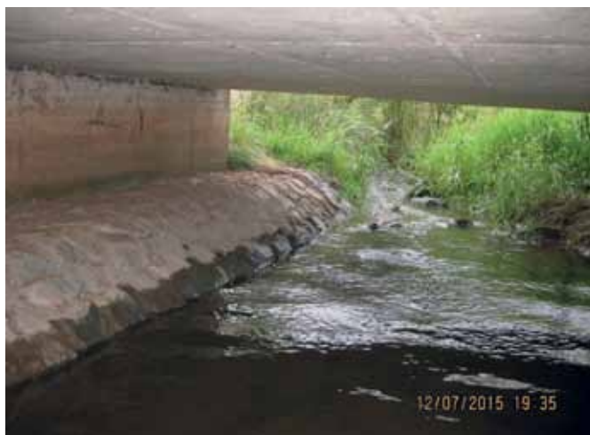
ABB. 30: NEU ERRICHTETE, GEMAUERTE BERME MIT RAUHER OBERFLÄCHE (FOTO M. SCHMALZ)
