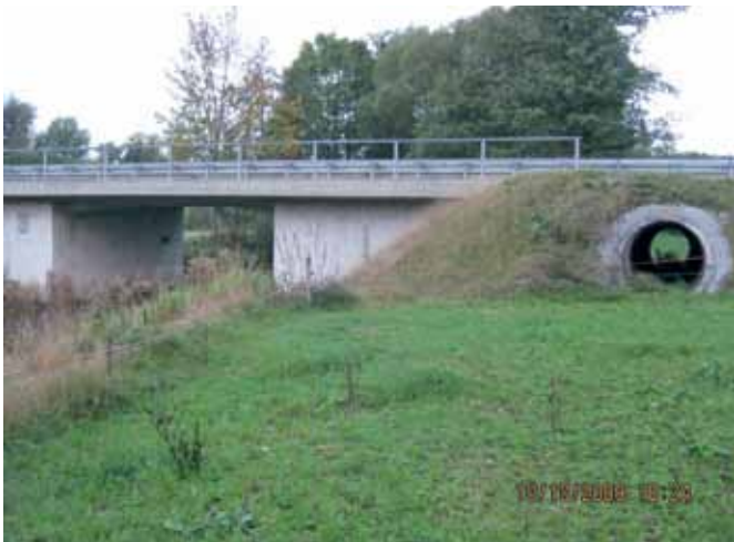
Abb. 22: TROCKENTUNNEL (OHNE LEITZÄUNUNG, FOTO M. SCHMALZ)
