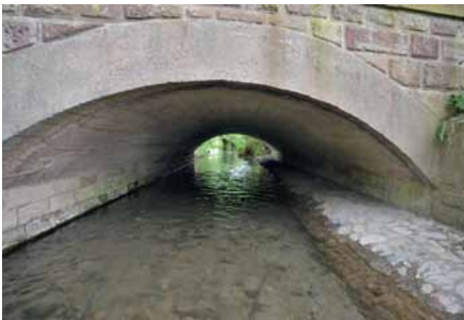
FERTIG GESTELLTE BERME (FOTO S. GUNKEL)
