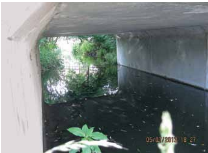
Abb. 42: ...WELCHER DIE BERMEN DER BRÜCKE KOMPLETT EINSTAUT (FOTOS M. SCHMALZ)
