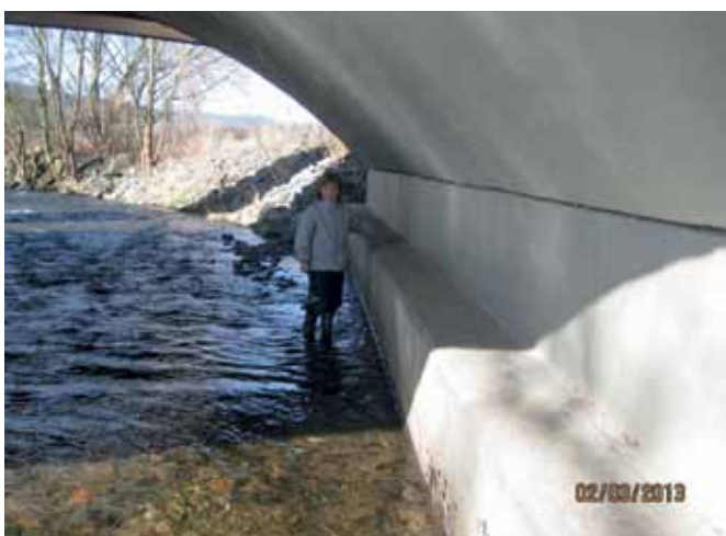
Abb. 17: LAUFSTEG MIT 30 CM BREITE, DER VOM OTTER GUT ANGENOMMEN WIRD (FOTO M. SCHMALZ)
