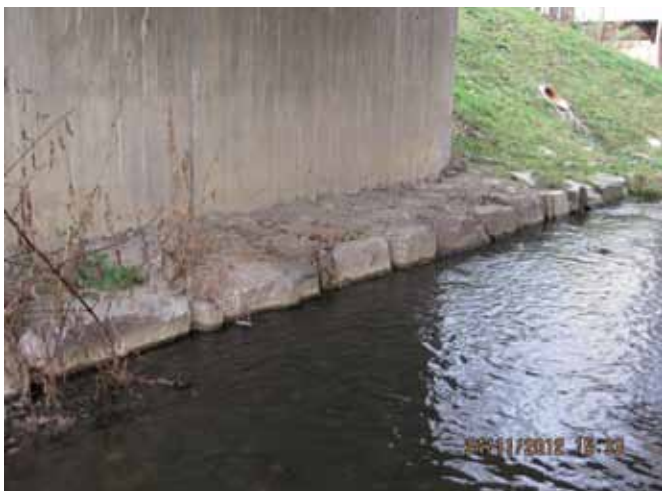
Abb. 7: BRÜCKE MIT GESETZTEN WASSERBAUSTEINEN (Foto M. SCHMALZ)
