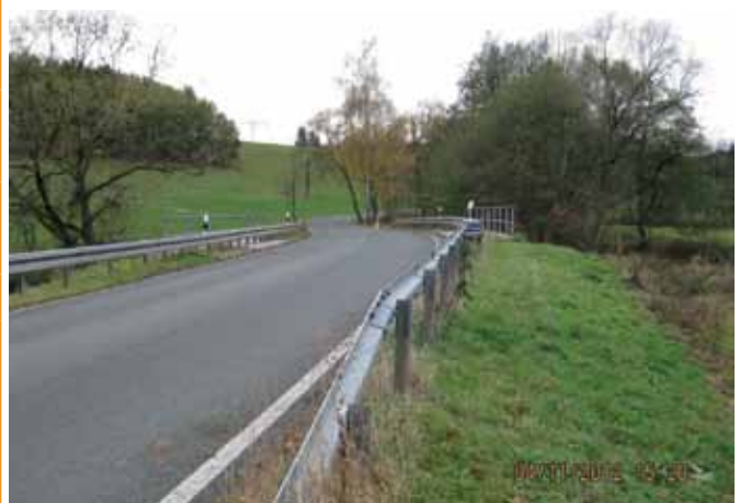
STRASSE K 209 IM BRÜCKENBEREICH (FOTO M. SCHMALZ)
