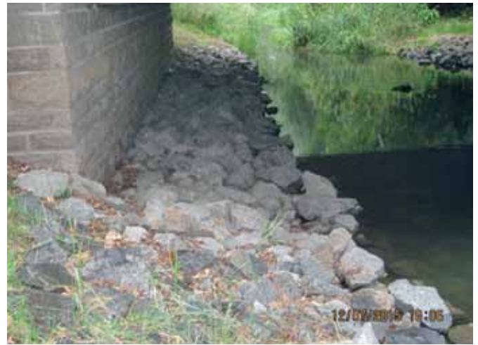
Abb. 28: Neu errichtete Berme als Steinschüttung (Foto M. Schmalz)
