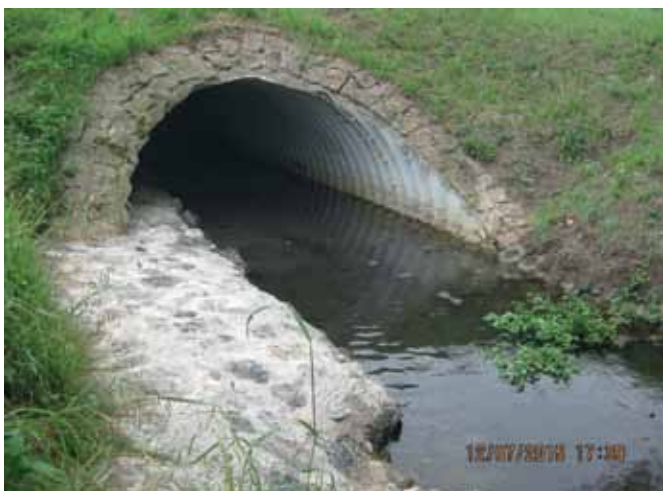
Abb. 34: GEMAUERTER UFERANSCHLUSS (FOTO M. SCHMALZ)
