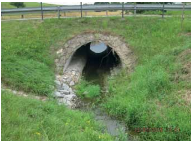
Abb. 33: BERME MIT UFERANSCHLUSS ALS STEINSCHÜTTUNG (FOTO M. SCHMALZ)
