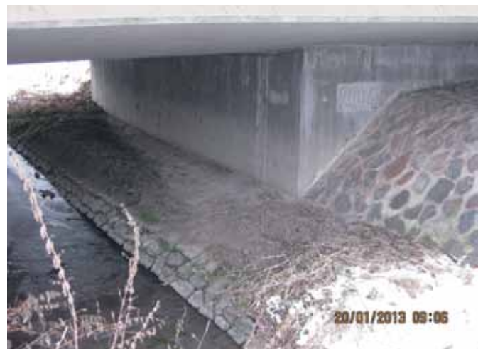
Abb. 24: Geringe Gefährdung: Gemauerte Berme mit Sedimentablagerung (Foto M. Schmalz)
