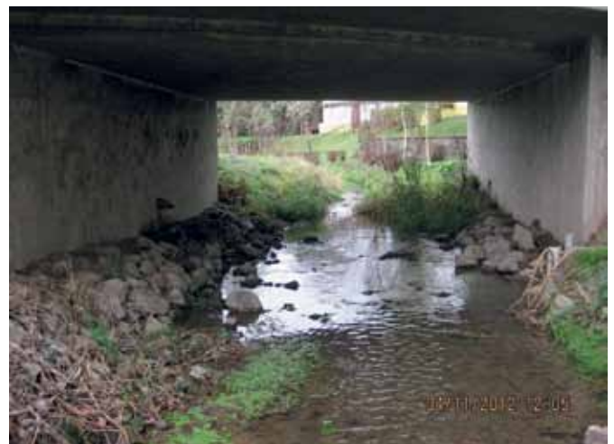
Abb. 9: EINFACHE STEINSCHÜTTUNG, DIE BEI HÖHEREM WASSERSTAND SCHNELL ÜBERSCHWEMMT IST (Foto M. SCHMALZ)
