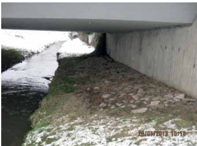
Abb. 8: OPTIMALE BERME AUS UNREGELMÄßIG GESETZTEN STEINEN, DIE TEILWEISE MIT NATÜRLICHEM SEDIMENT BEDECKT SIND (Foto M. SCHMALZ)
