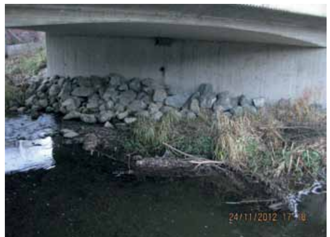
Abb. 10: ZU STEIL AUSGEFÜHRTE STEINSCHÜTTUNG OHNE EBENEN BEREICH (Foto M. SCHMALZ)
