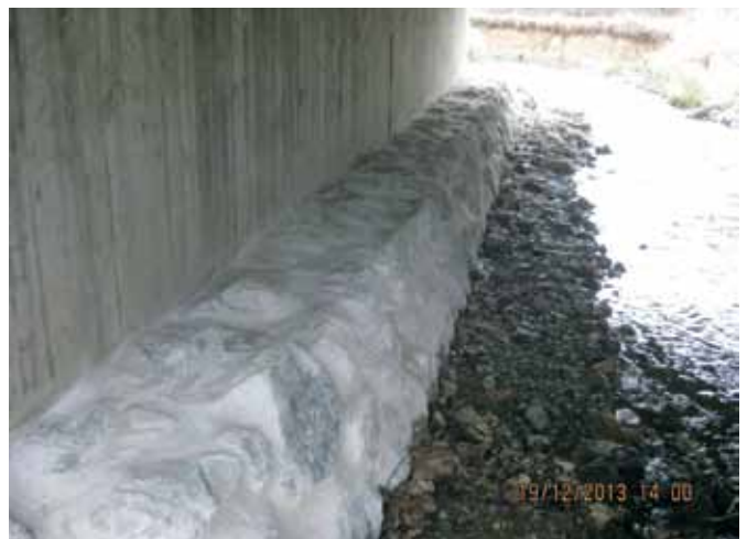
Abb. 13: ERHÖHTE BERME, DIE AUCH BEI MITTELWASSER NICHT ÜBERSÜLT WIRD (FOTO M. SCHMALZ)
