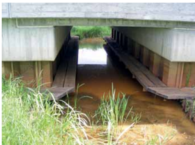
Abb. 20: Laufbretter unter einer Brücke (Foto: A. Weber)
