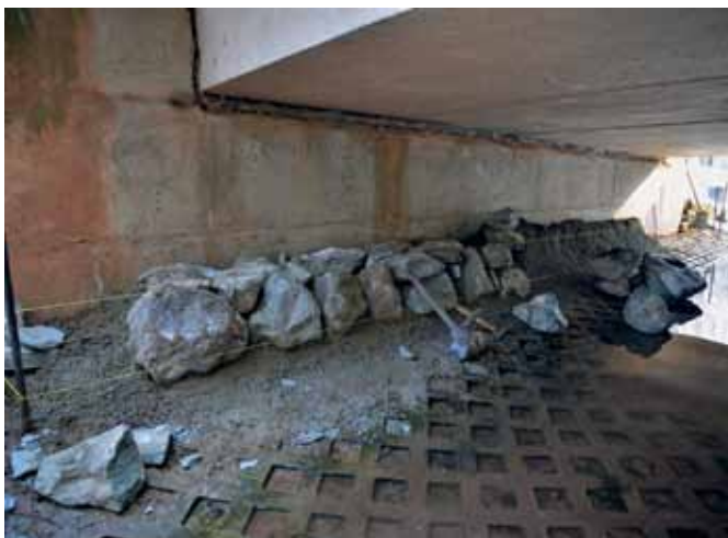
ABB. 29: BAUARBEITEN AN EINER BRÜCKE MIT BETONIERTER BERME. IN DEN BETON WERDEN GROßE STEINE EINGEFÜGT, UM EINE NATURNAHE RAUIGKEIT ZU ERHALTEN (FOTO S. GUNKEL)
