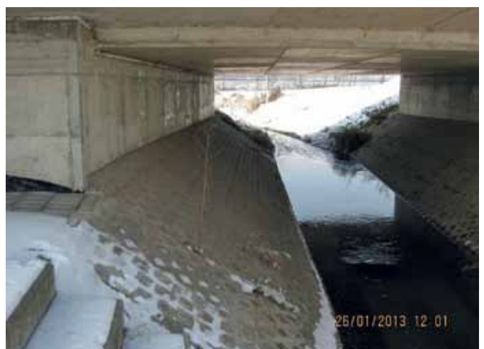
Abb. 14: STEILE NEIGUNG DER BERME, KEIN EBENER BEREICH. DIE RAUIGKEIT DER RASENGITTERSTEINE LÄSST DENNOCH EINE EINGESCHRÄNKTE NUTZUNG ZU (FOTO: M. SCHMALZ)
