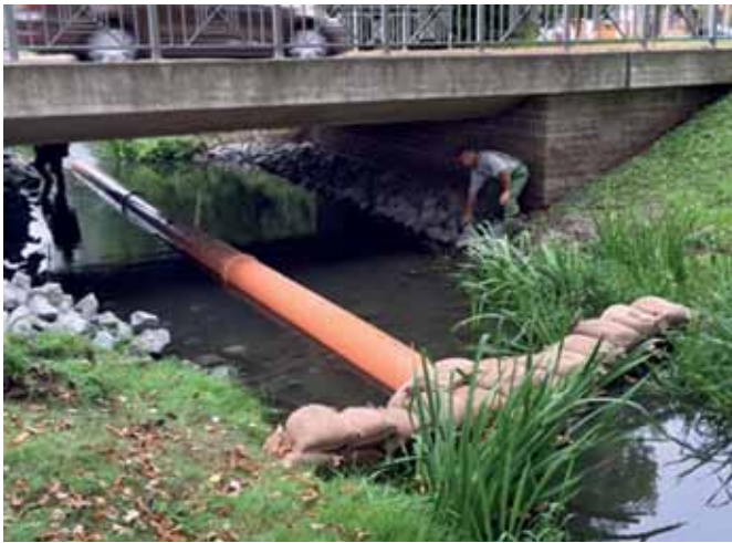
Abb. 27: Arbeiten an einer Brücke mit Steinschüttung. Die Absenkung des Wasserspiegels für die Bauarbeiten erfolgt durch ein Rohr. (Foto S. Gunkel)
