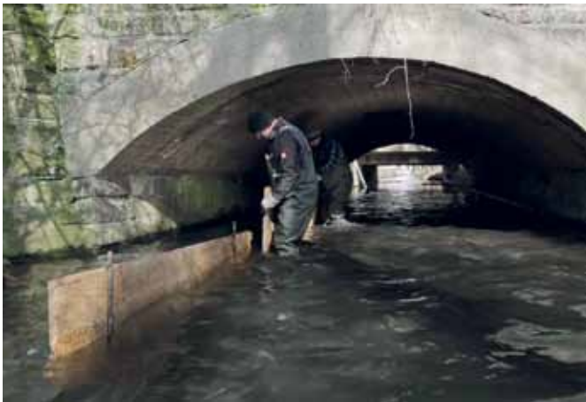
BAUARBEITEN AN DER BRÜCKE (FOTO LODRUM)
