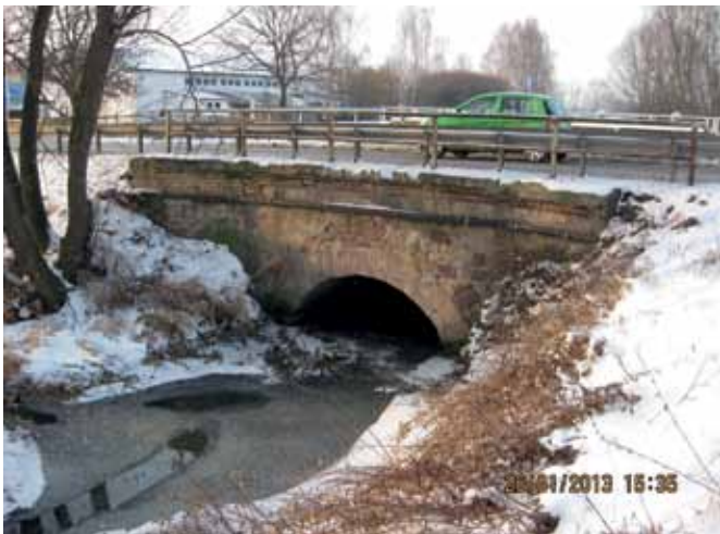
ABB. 26: HOHE GEFÄHRDUNG: BRÜCKE OHNE BERME, DIE ZUSÄTZLICH DURCH EINE STAUVORRICHTUNG AUF DER ANDEREN SEITE EINGESTAUT WIRD (FOTO M. SCHMALZ)
