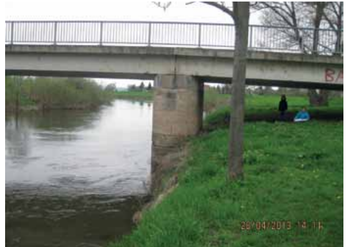
Abb. 45: PFEILERBRÜCKE MIT FEHLENDEN BERMEN DIREKT AM GEWÄSSER, ABER DENNOCH GUTER PASSAGEMÖGLICHKEIT (FOTO M. SCHMALZ)
